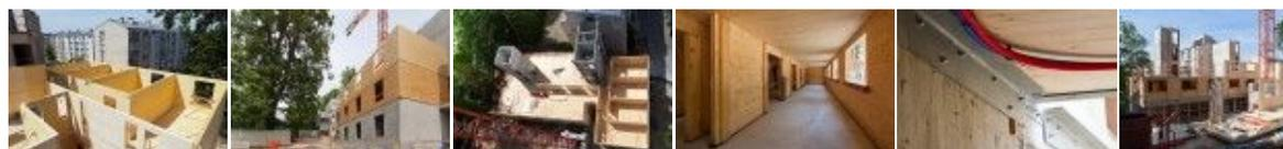
Une résidence de 60 studios pour étudiants, en cours de construction à Versailles, est constituée de quatre étages en panneaux de bois massif (murs et planchers), sur un socle en béton.
