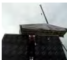
Installation de la toiture provisoire
