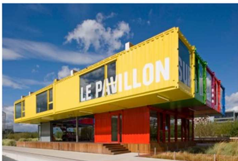
© Le pavillon sur l'Île Seguin - MAN Architectures Le pavillon réalisé par l'agence Man Architectures au cœur de l'Île Seguin, à Boulogne-Billancourt (Hauts-de-Seine).
