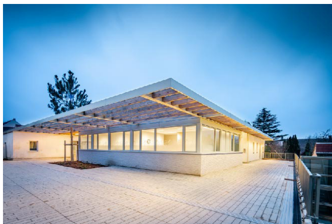
CONSTRUCTION D'UNE STRUCTURE MULTI-ACCUEIL PETITE ENFANCE Noisy-le-Roi (78)
