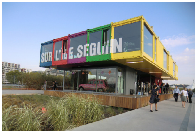
PAVILLON D'INFORMATION SUR L'ILE SEGUIN Boulogne Billancourt (92)
