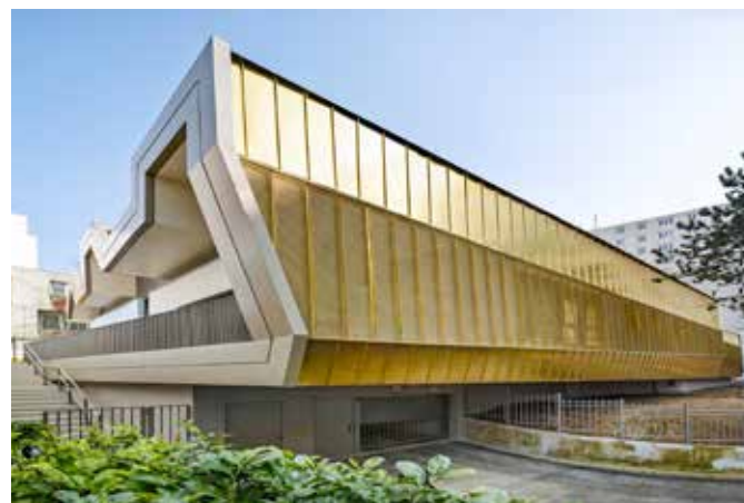
CONSTRUCTION D'UNE CRECHE DE 44 BERCEAUX 46, rue Piat – Paris 20ème
