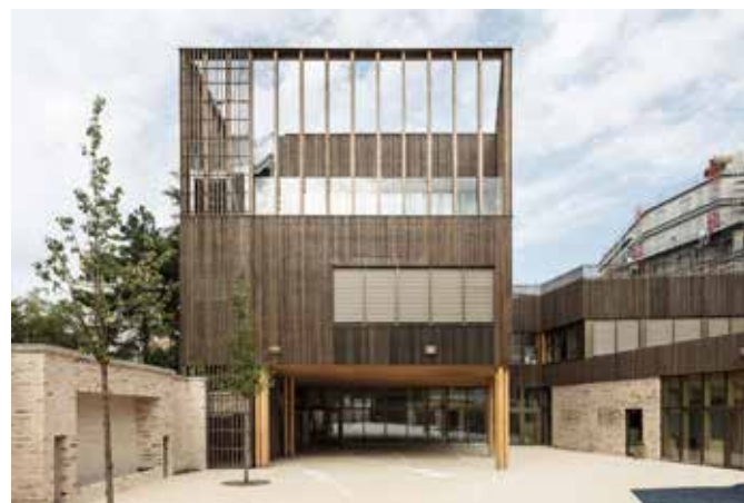
RECONSTRUCTION/EXTENSION D'UNE ECOLE MATERNELLE DE 6 CLASSES 90, boulevard Vincent Auriol - Paris 13ème
