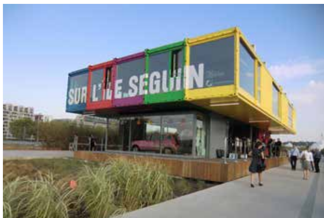
PAVILLON D'INFORMATION SUR L'ILE SEGUIN Boulogne Billancourt (92)
