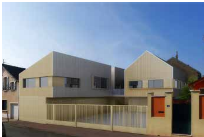
RESTRUCTURATION DE BUREAUX EXISTANTS ET EXTENSION Saint-Maur-Des-Fossés (94)
