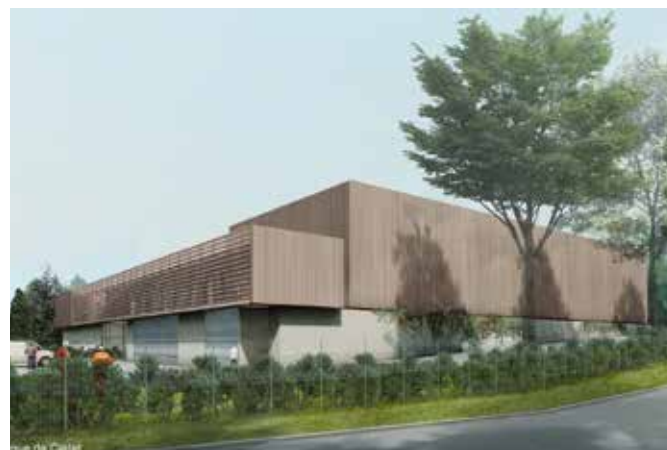
CONSTRUCTION DU NOUVEAU CENTRE TECHNIQUE MUNICIPAL Chilly Mazarin (91)
